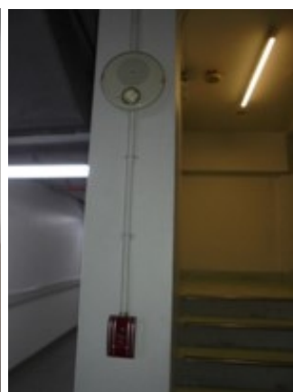
ลิฟต์ดับเพลิง เครื่องส่งสัญญาณโดยใช่มือดึง
