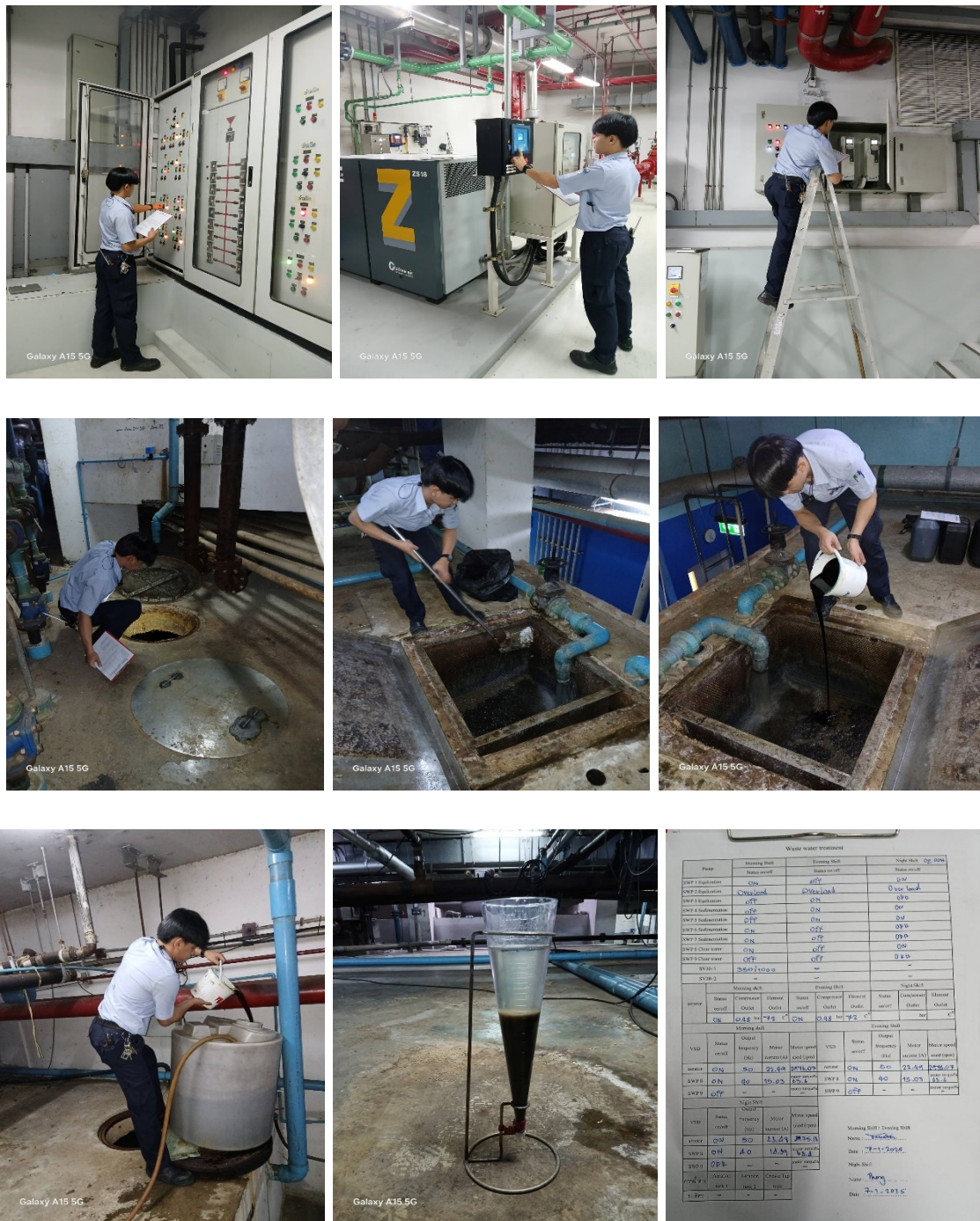
ภาพที่ 3-34 การตรวจสอบดูแลซ่อมบำรุงระบบบำบัดน้ำเสีย
