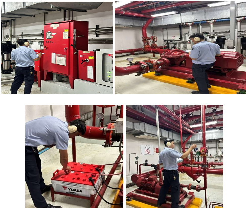
ภาพที่ 3-36 ตรวจสอบดูแลซ่อมบำรุงระบบสูบน้ำดับเพลิง (Fire Pump)
