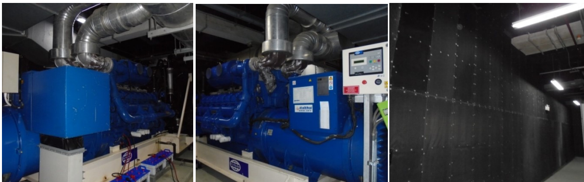
ที่ 3-26 ห้องเครื่องไฟฟ้าฉุกเฉินมีระบบขนวนป้องกันเสียงดัง ปล่องไอเสีย และเครื่องตรวจจับความร้อน
