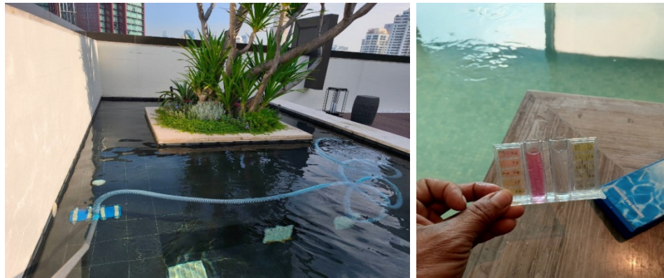
ภาพที่ 3-38 ดูแลรักษาสระว่าน้ำและตรวจวัดค่า pH , Chlorine Free เป็นประจำทุกวัน
