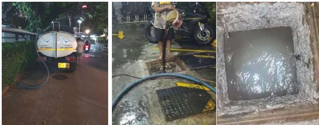
สูบล้างปลวกออกจากบ่อดักไขมัน และเดิมสารชีวภาพในบ่อดักไขมัน ภาพที่ 3-27 ดูตะกอนไขมันและตะกอนในบ่อกักเก็บตะกอนของระบบบำบัดน้ำเสีย
